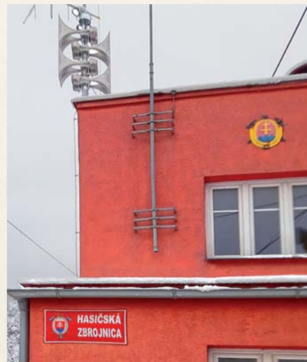
Na budovu požiarnej zbrojnice bola namontovaná nová elektronická siréna.
