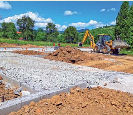
Na pozemku vedľa zdravotného strediska sa začína s výstavbou Domu seniorov.
