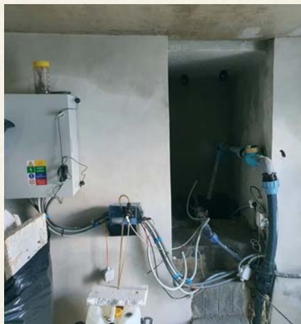
Rekonštrukcia sa dotkla aj vnútorných priestorov vodojemu.
