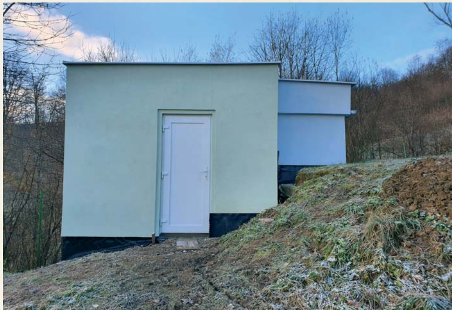
Budova vodojemu Ritvina bola zrekonštruovaná.
